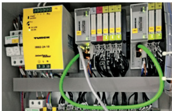
Turcks RFID- und I/O-System BL20 sorgt für die zuverlässige Kommunikation zur SPS
