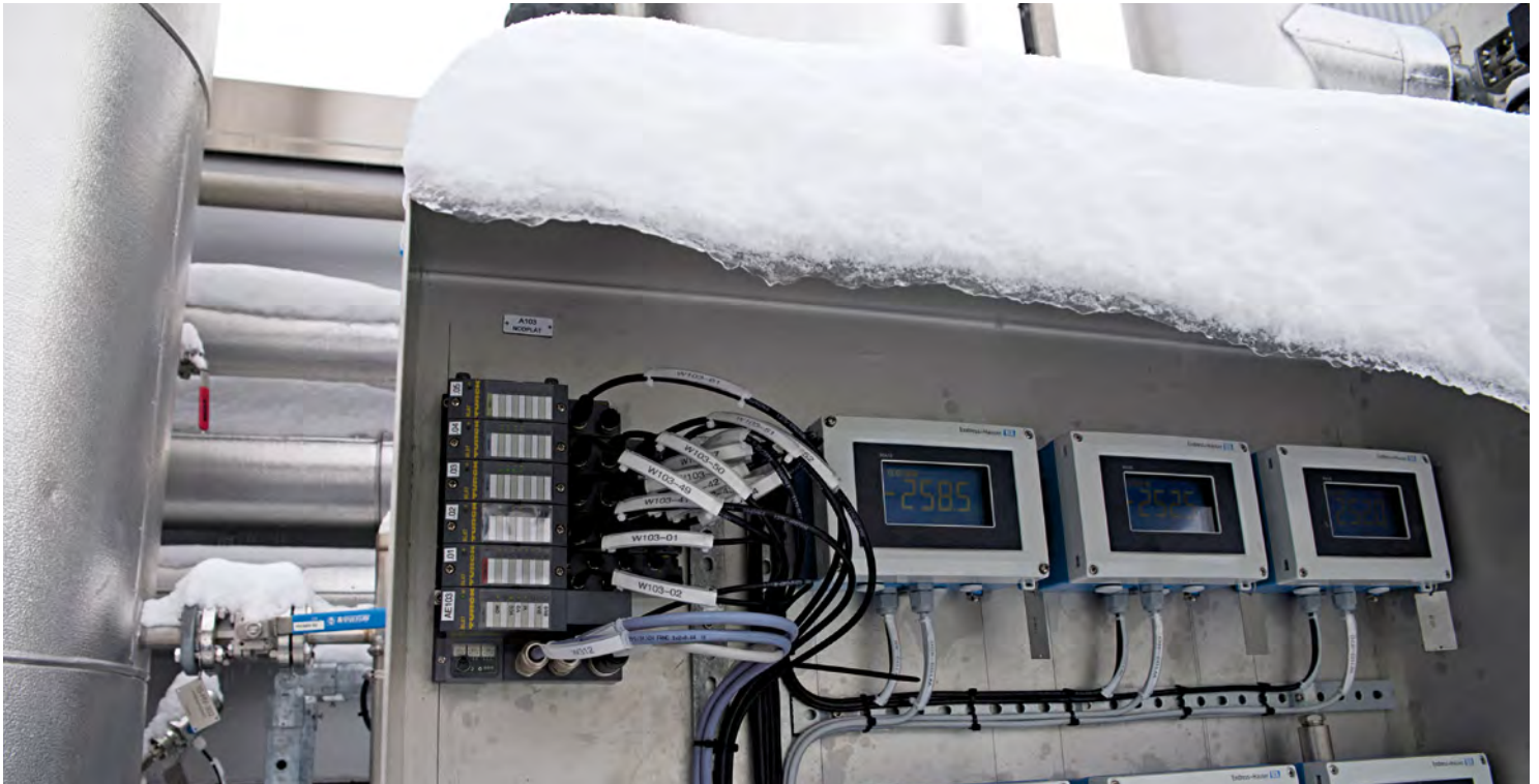
Mit einem Temperaturbereich bis zu -40^{\circ}\text{C} widersteht Turcks BL67-System sogar dem schwedischen Winter
