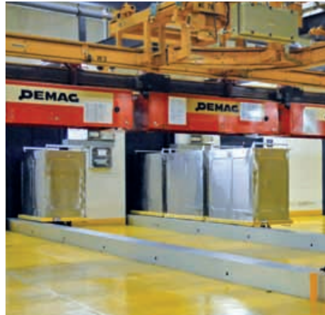
Bevor die Container in einen der 39 Aufzüge einfahren,
